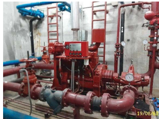
เครื่องสูบน้ำสำหรับดับเพลิง
