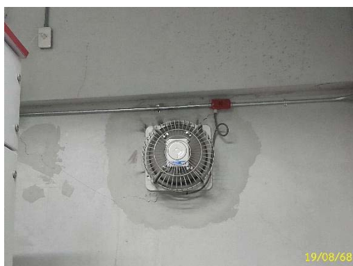
พัดลมระบายอากาศห้องเครื่อง
